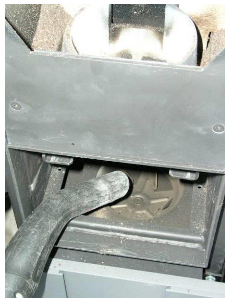
Fig. 86: fan cleaning
