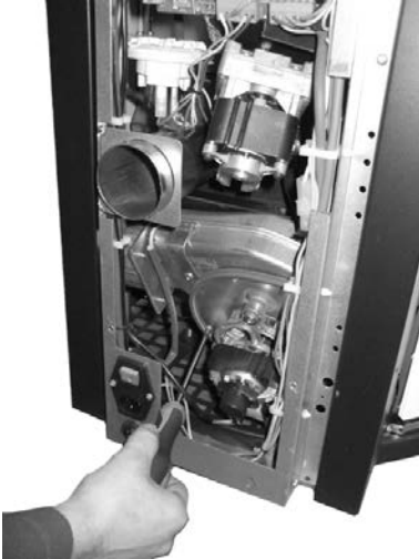
Fig. 103 - Fume fan cleaning: phase 1
