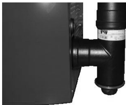
Fig. 83 - Fume conduit cleaning
