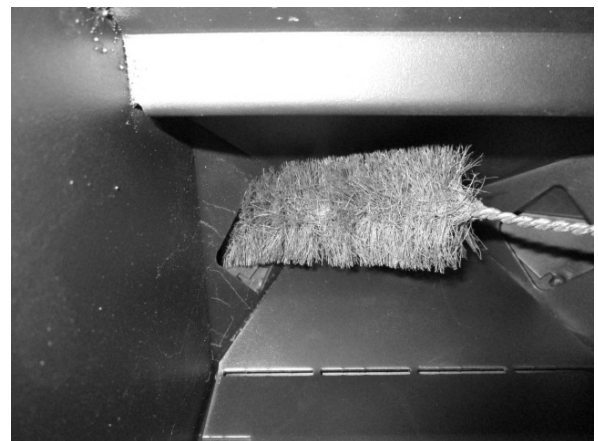
Fig. 44 - Reiniging met pijpenwisser 4
