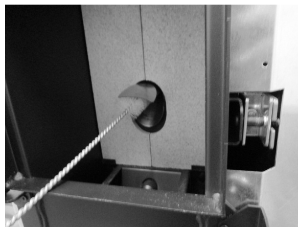
Fig. 23 - Reiniging met flessenwisser
