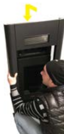
Fig. 24 - Positionering van de lijst
